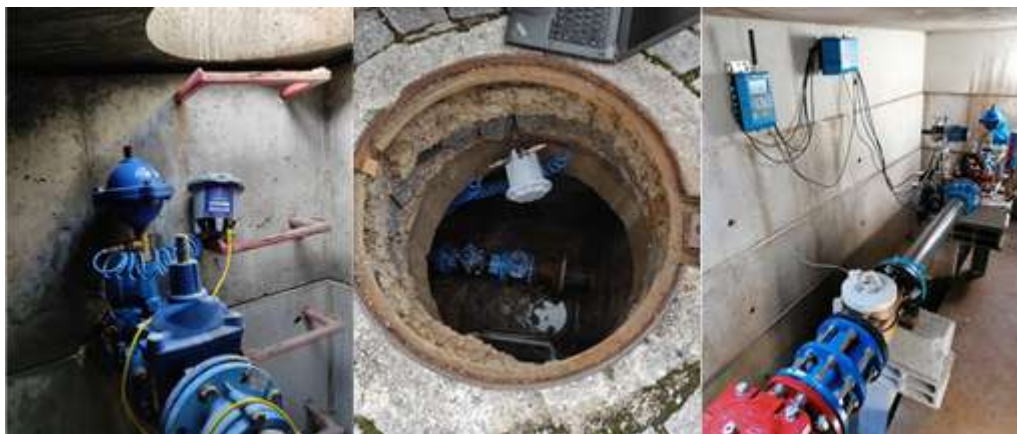
Instalações na rede de abastecimento (VRP, Dataloggers)
