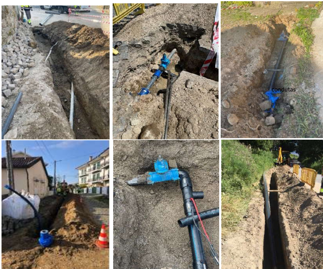
Execução de obras de instalação de condutas
