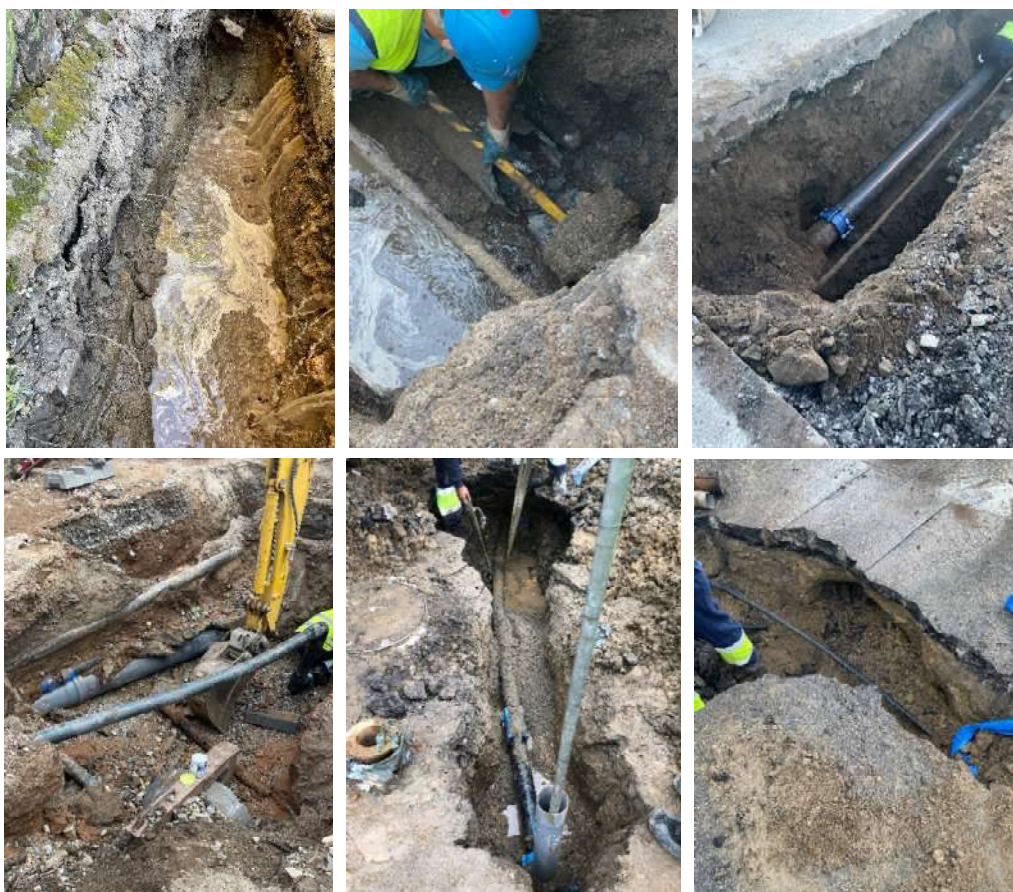
Reparação de avarias em condutas e ramais
