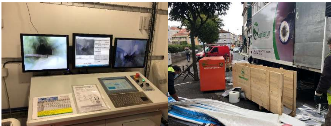
Reabilitação de coletores sem abertura de vala, com recurso ao método Cured in Place Pipe (CIPP) com cura UV
